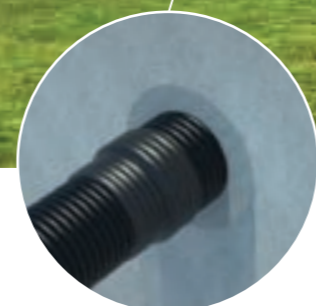
Prehod preko stene – za površinske vode
