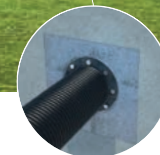
Prolaz kroz zid – blokada vode pod pritiskom
