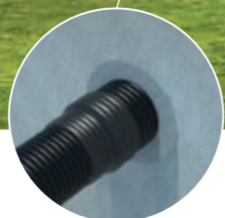
Prolaz kroz zid – otpornost površinskim vodama
